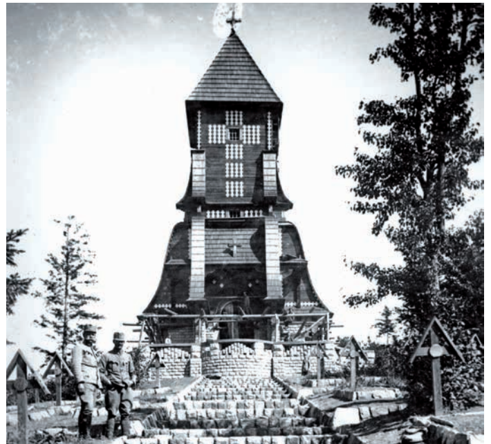
Kaplnka na cintoríne Lužna, Pustki, počas výstavby, 1916
