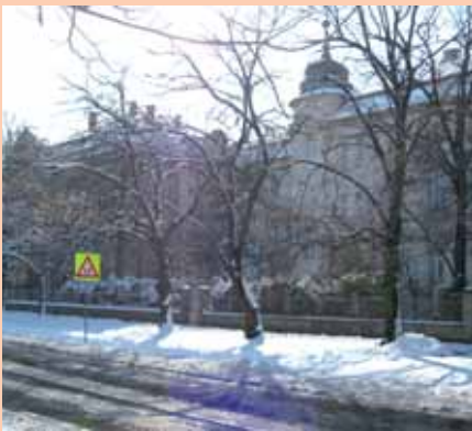
Celkový pohľad na školskú budovu
