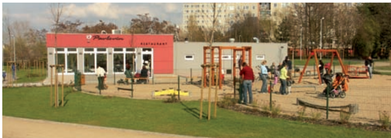
Celkový pohľad na reštauráciu Pavlovín v Prahe 4
